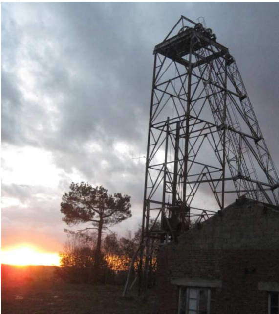
Heures sombres sur Montbelleux
