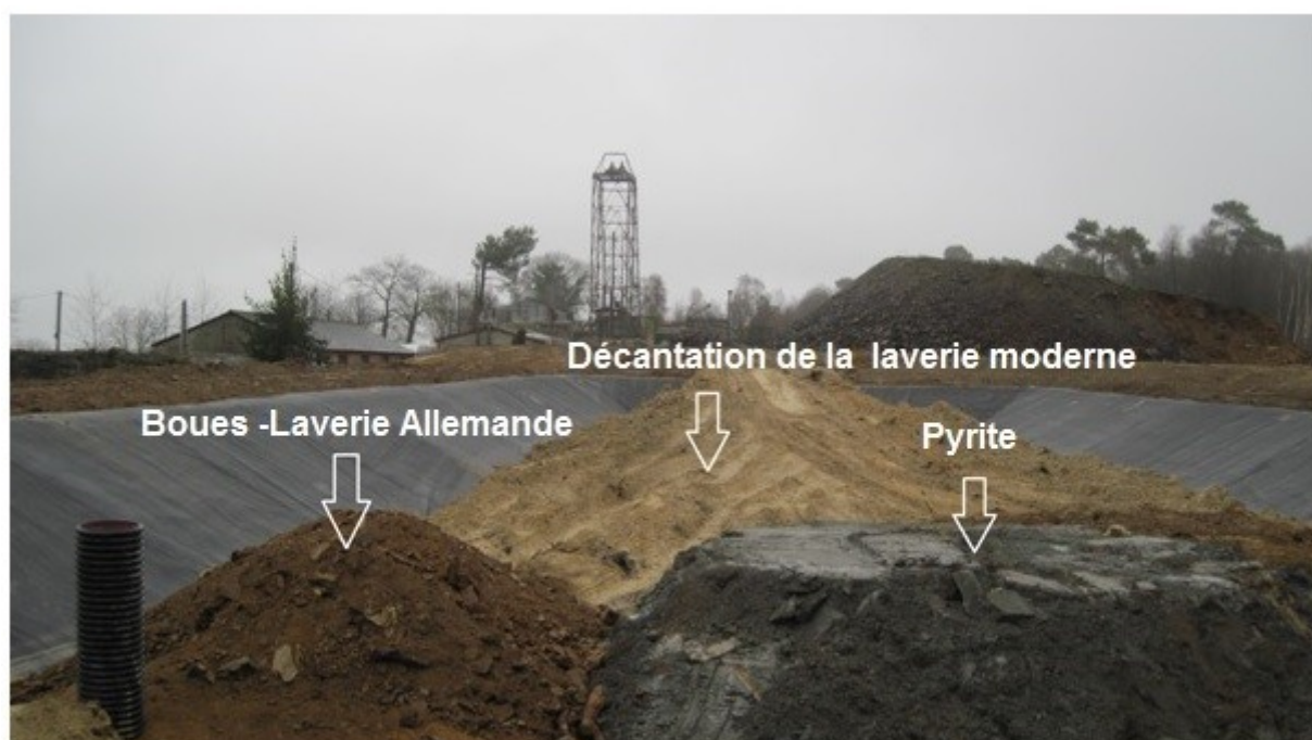
Alvéole de stockage des déchets sur place dans géomembrane - 2012
