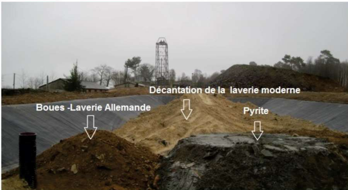
Alvéole de stockage des déchets sur place dans géomembrane - 2012
